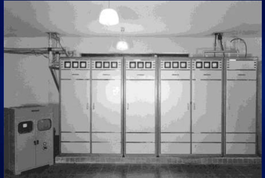
Fernsehbild-Rundfunk-Sender 1 kW (6. OG)
